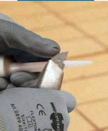
Отрязване на дюзата според размера на фугите
