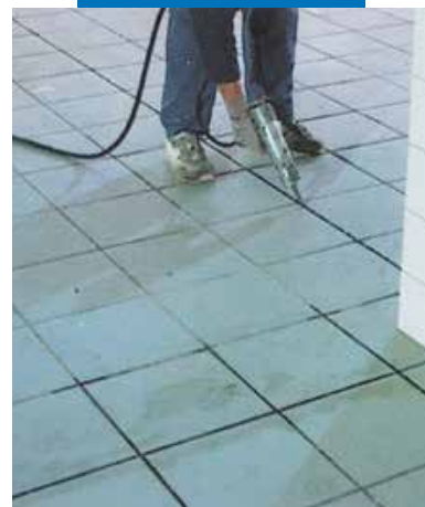
Уплътняване на под с керамични плочки с Mapesil AC
