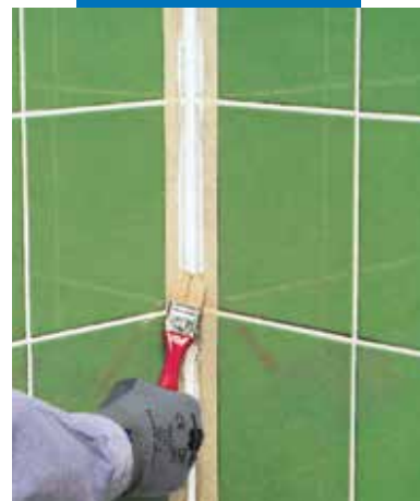
Заглаждане на фугата с малка четка и сапунена вода
