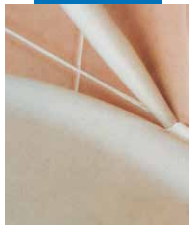
Уплътняване на санитарно оборудване
